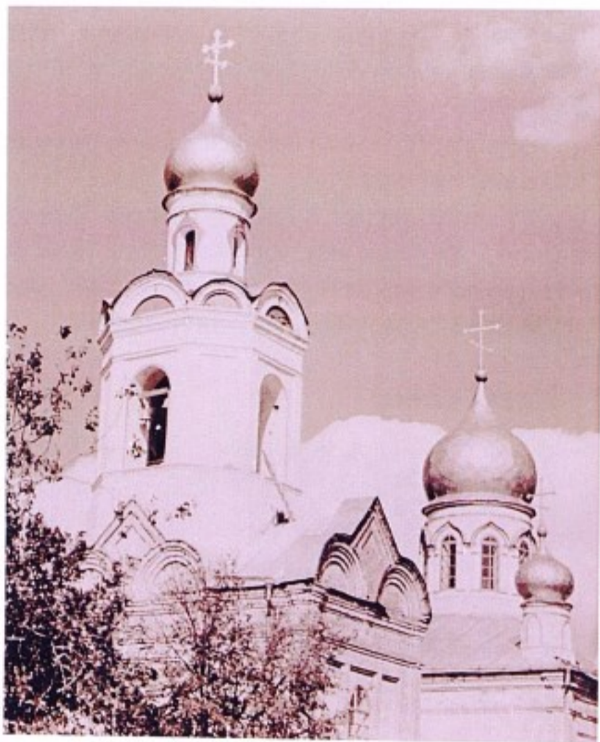
Покровская церковь с. Русский Илек. 2000 г.
