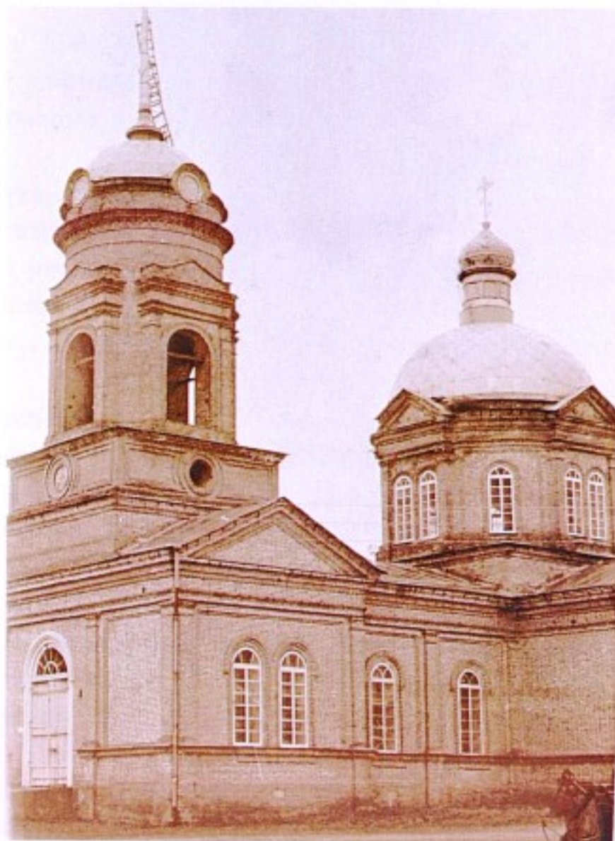
Покровская церковь с. Бобрава. 2000 г.
