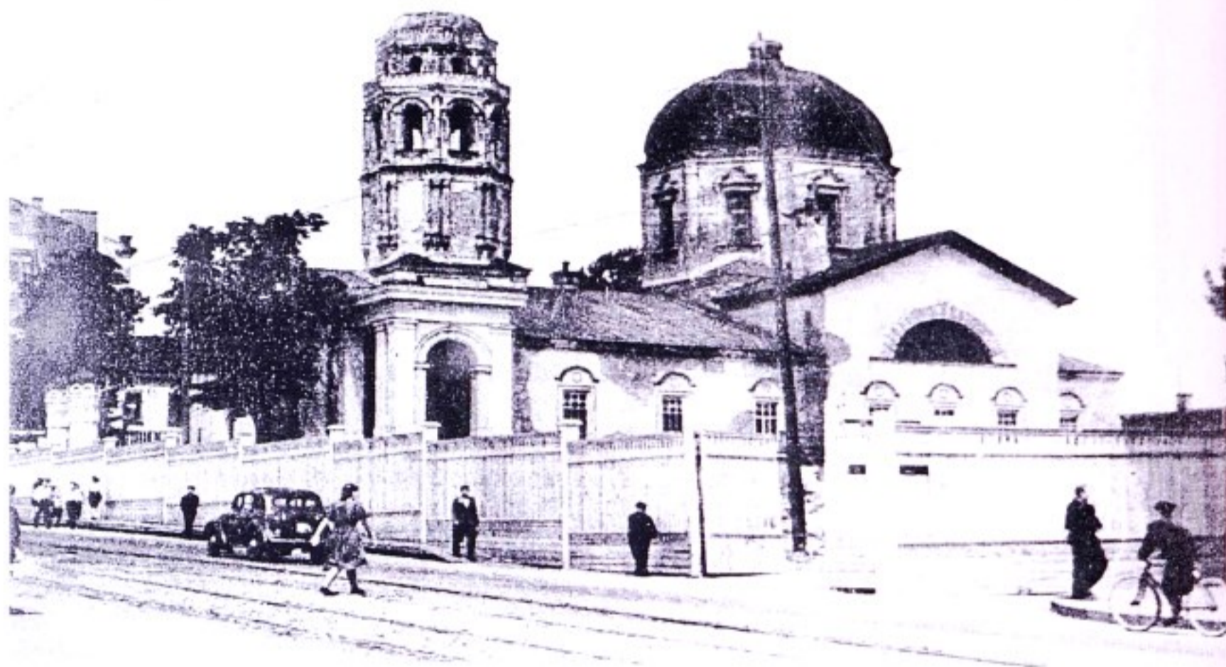
Общий вид Ильинской церкви. На этом месте будет построен Дом Книги. 1949 г.
