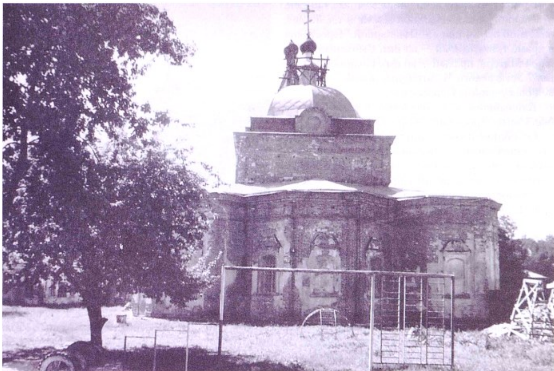
Смоленский храм г. Обояни. Начало реставрационных работ. 1996 г.
